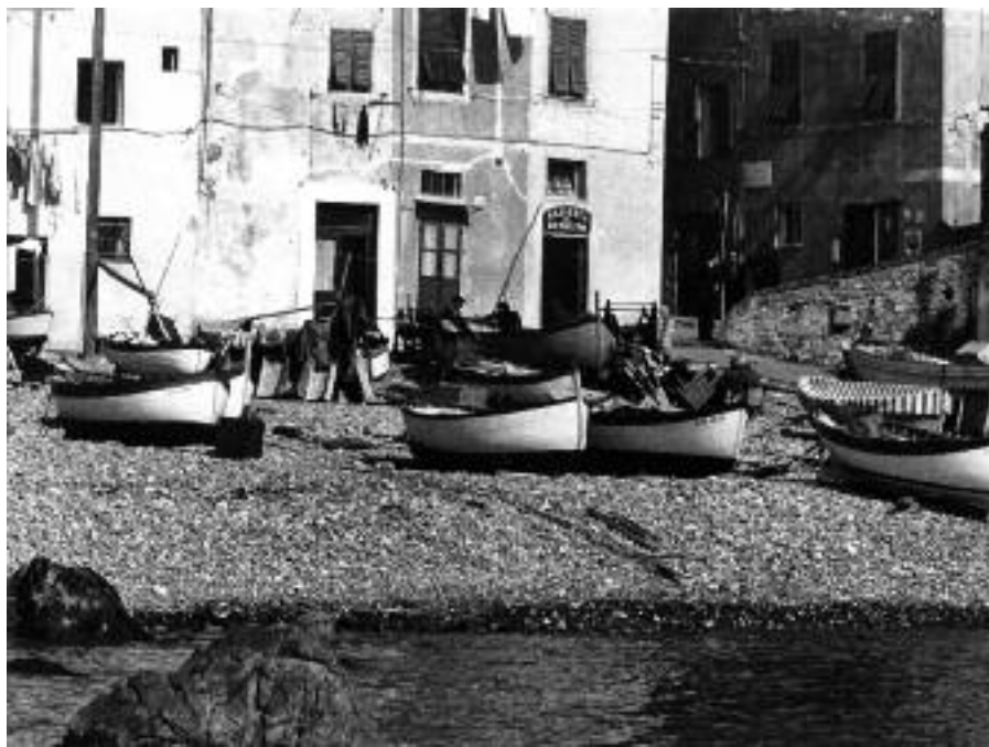
La Galleria del Deposito sulla spiaggia di Boccadasse, 1963. Foto Kurt Blum
